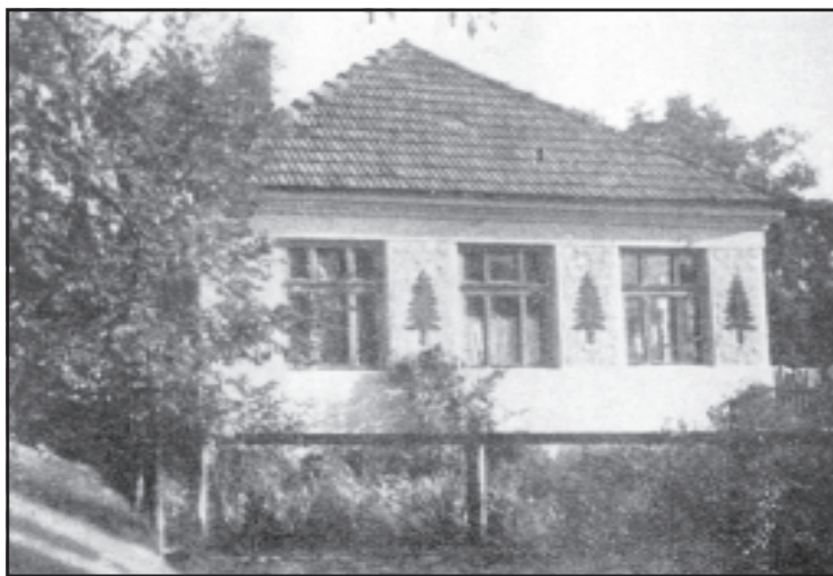
Casa lui Gogan Umberto făcută din cărămidă și acoperită cu țiglă în stil de oraș. Pe tencueala zidului este aplicat un motiv floral ornamental: bradul verde
